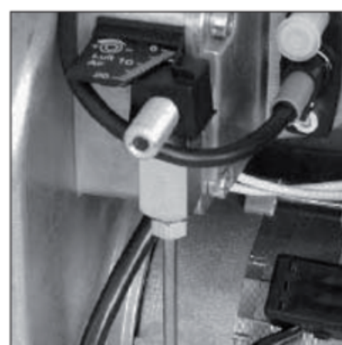
Рис. 16: Регулировка подпорной шайбы горелки
